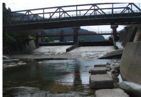
〔定点6：黒谷堰堤下〕
