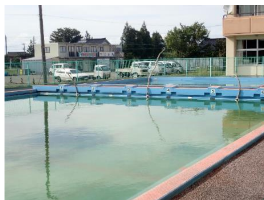
写真6 設置された流木(星の杜小)
