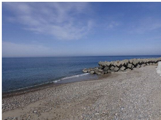
写真 17 寿町地先の波打ち際
