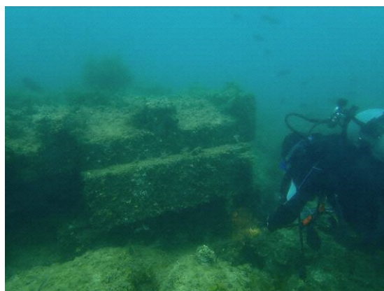
写真11 青島地先のコンクリート製の人工漁礁
